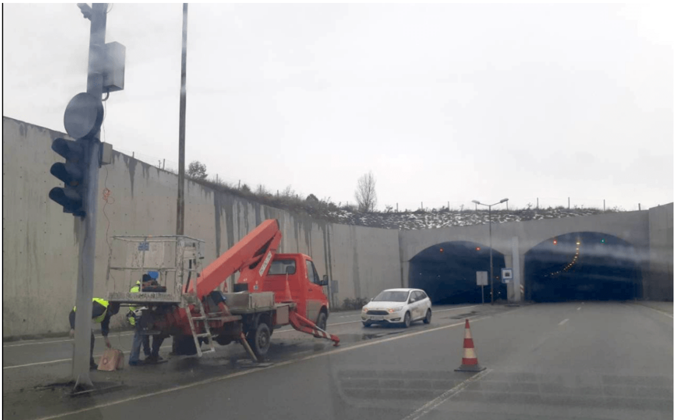
Ремонти на тунела Мало Бучино
